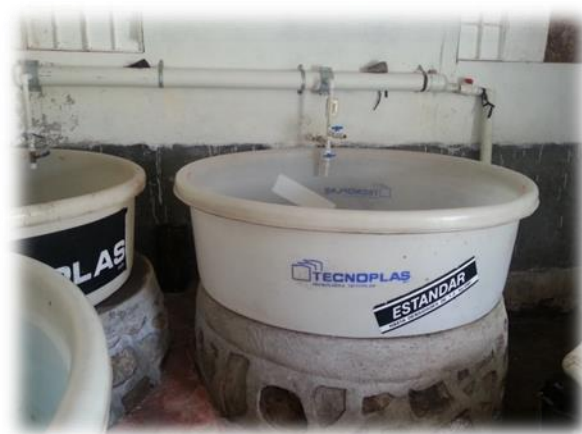
Foto 3. Mejora en la instalación hidráulica
