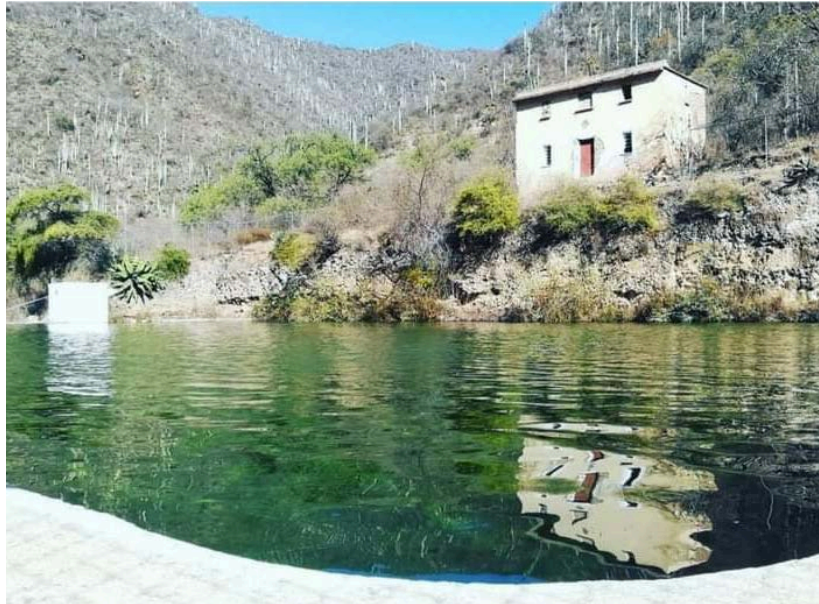
Imagen 1. La caja de agua; depósito de agua potable de Tehuacán, Puebla
