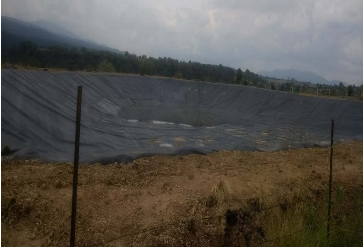
Figura 3. Colocación de geomembrana en el bordo de agua
