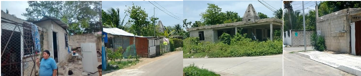
Imagen 2. Vivienda precaria en la Colonia Nuevo Progreso
