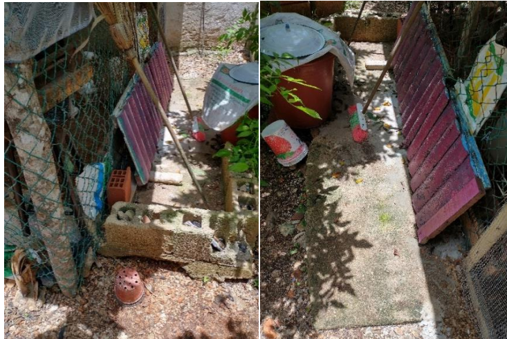
Imagen 4. Fosas sépticas utilizadas en las viviendas
