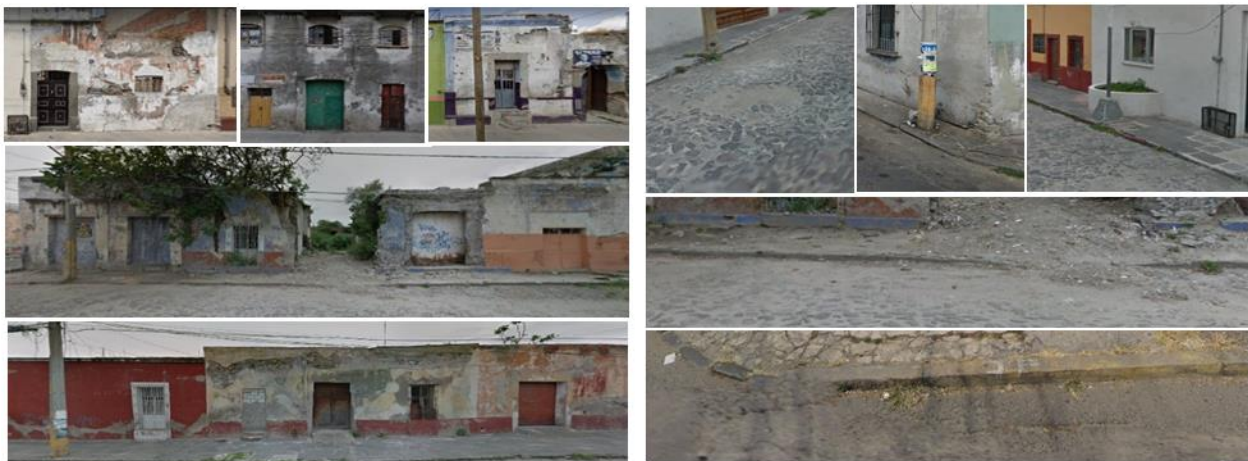
Figura 4: Estado actual de fachadas e inmuebles de la avenida 7 orientes, así como material y aceras que son obstruidas por postes de luz y jardineras.
