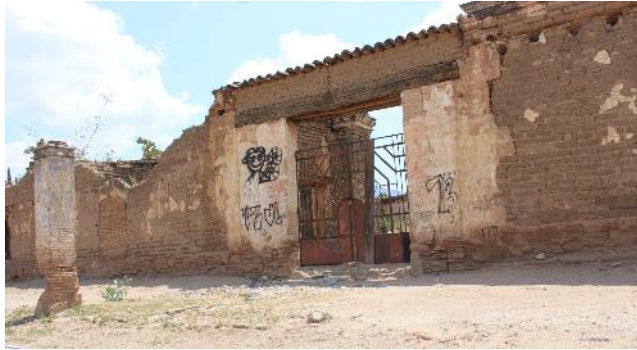
Imagen 10. Construcción de una vivienda con adobe
