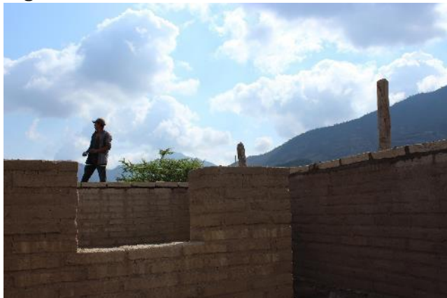
Imagen 9. Construcción de una vivienda con adobe
