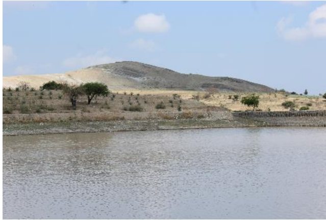
Imagen 7. Presa “Sin Nombre”
