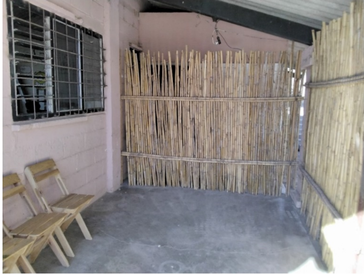
Imagen 5. Sala de juntas con pared de material de carrizo
