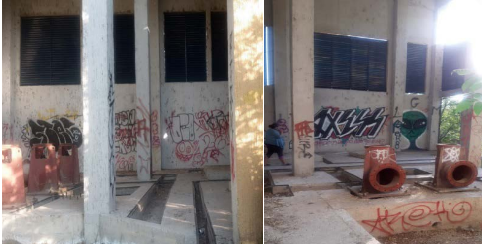
Imagen 7. Planta tratadora de agua vandalizada y desmantelada en S1
