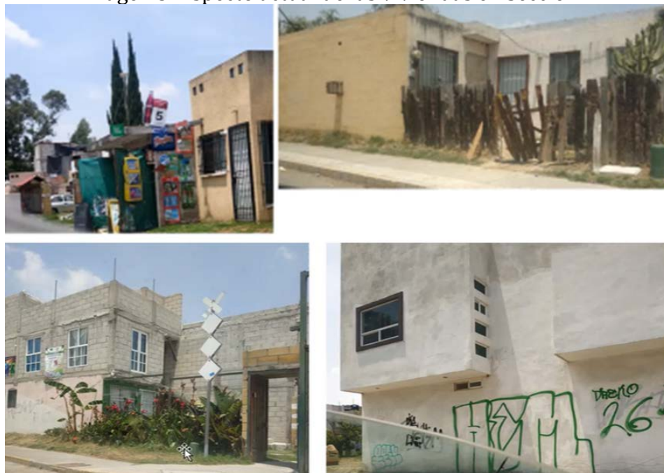
Imagen 5. Aspecto actual de las viviendas en Sección 1
